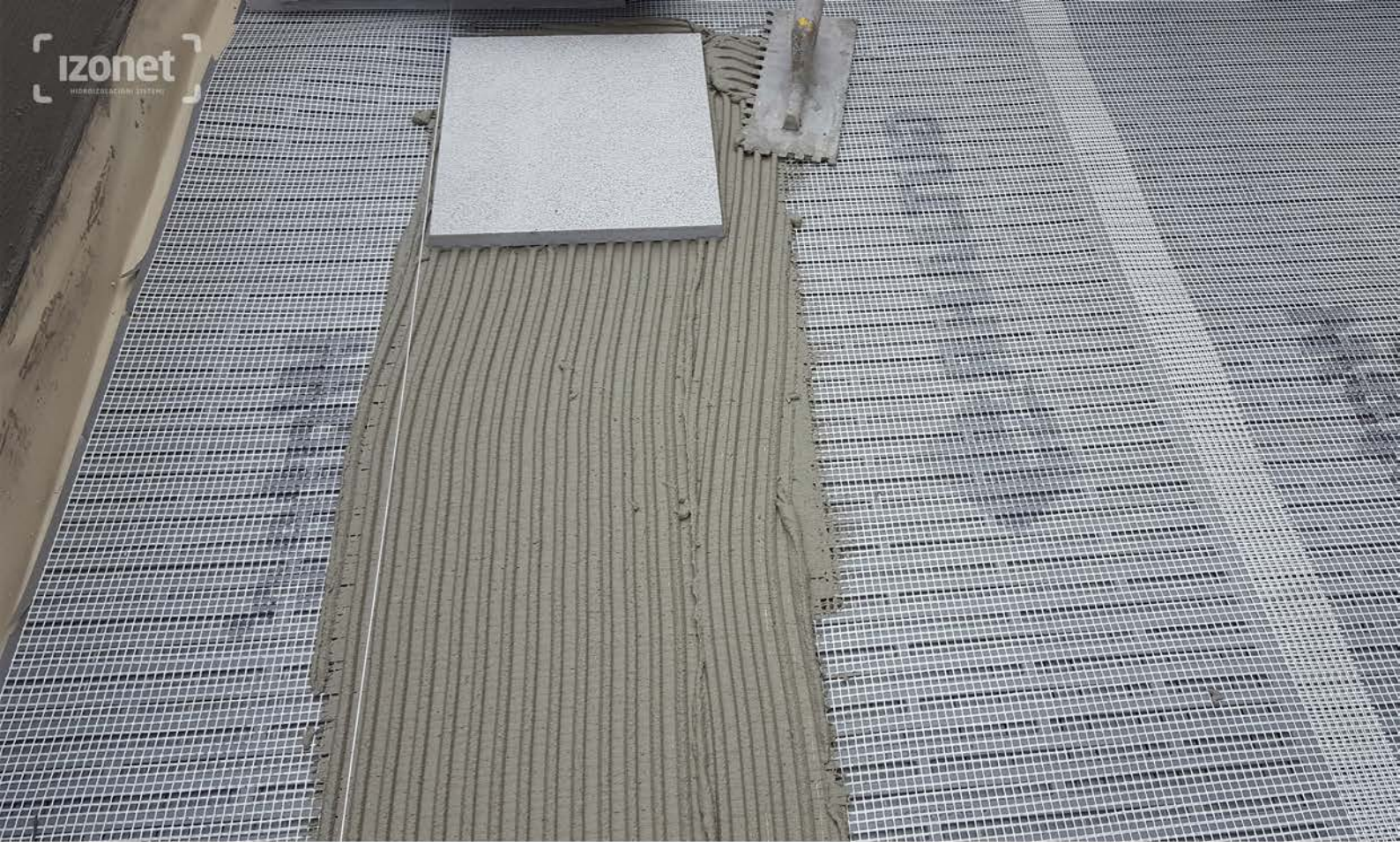
Slike sa naših gradilišta gdje smo uspješno ugrađivali Gutjahr proizvode.
